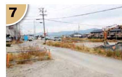
7 国道151号一宮バイパス
