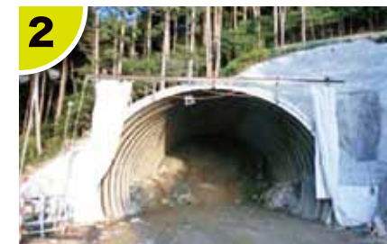
2 国道23号蒲郡バイパス 国坂トンネル工事
