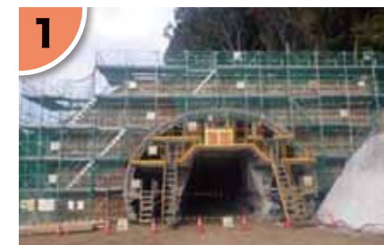
1 国道23号蒲郡バイパス 五井トンネル工事
