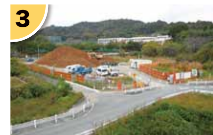
3 国道23号蒲郡バイパス 豊沢広石道路建設工事
