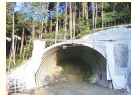
4. 国道23号蒲郡バイパスの整備
