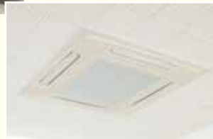
▶ 新設校舎の設置例 (写真：大府もちのき特支)
