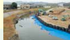
音羽川 工事現場
